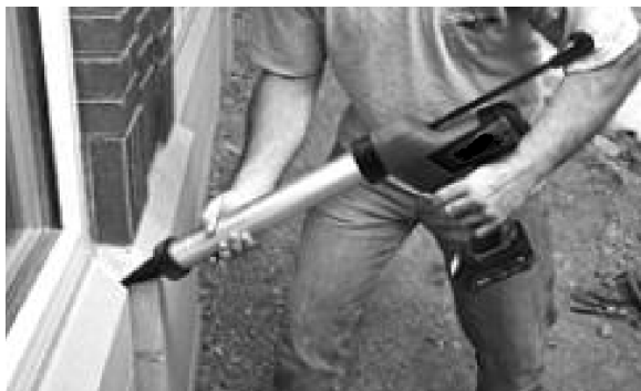
Рисунок 17. Робота з акумуляторним пістолетом для герметика.
